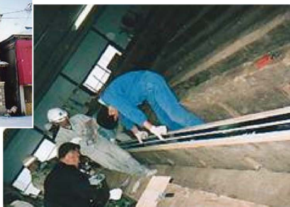
世界遺産 日光神橋（橋桁補強）
