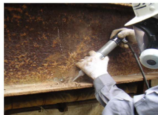
鋼材の素地調整（超音波振動剥離工法）
